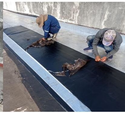
Colocado de la membrana asfáltica
