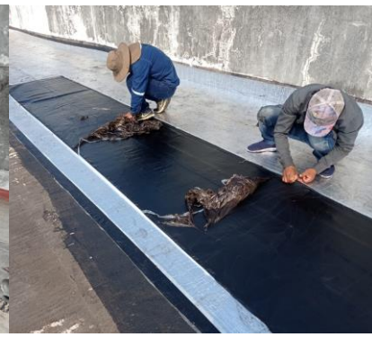
Colocado de la membrana asfáltica
