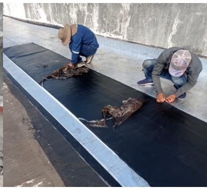
Colocado de la membrana asfáltica
