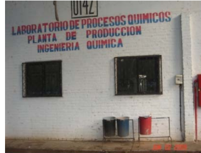
Campus - Contenedores diferenciados
