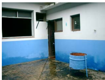
Edificio de la calle Ñuflo de Chavez Facultad Politécnica
