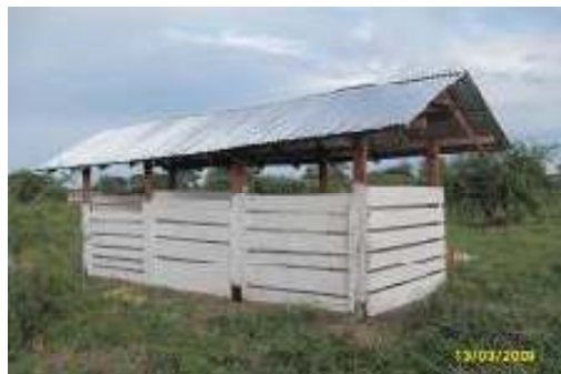
Caseta de compostaje
